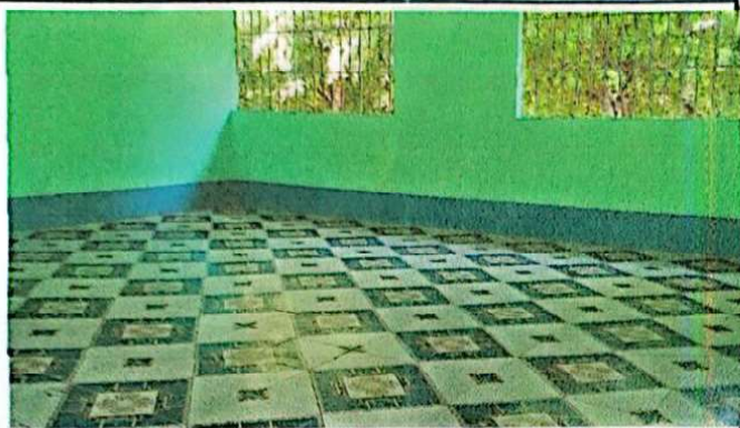
Foto1: Piso ceramico, aulas modulo 1
