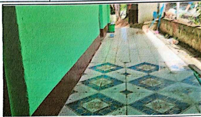
Foto 2: Piso ceramico en los corredores de las aulas, modulo 1.
