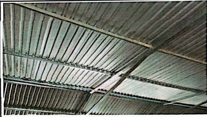
Foto 4: Costaneras y techo nuevo
